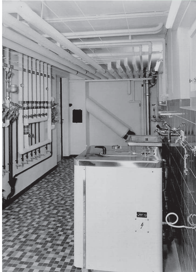
Waschküche mit vollautomatischer Waschmaschine und Gruppenunterteilung von Kalt- und Warmwasser für ein Wohn- und Geschäftshaus.
