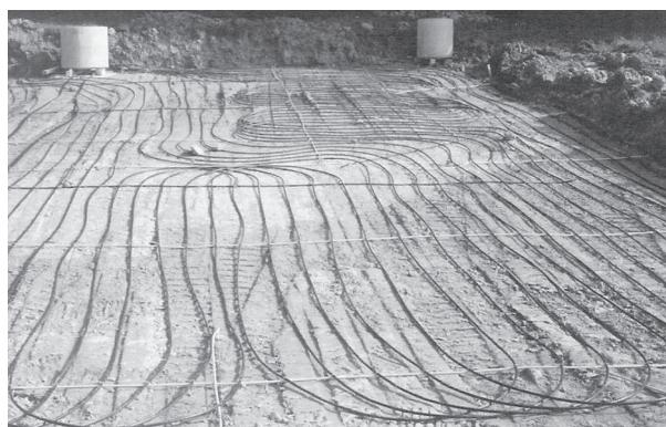
**Ins Erdreich verlegtes Rohrregister. Mit einer Wärmepumpe kombiniert wird die anfallende Erdwärme zu Heizzwecken ausgenützt.**
